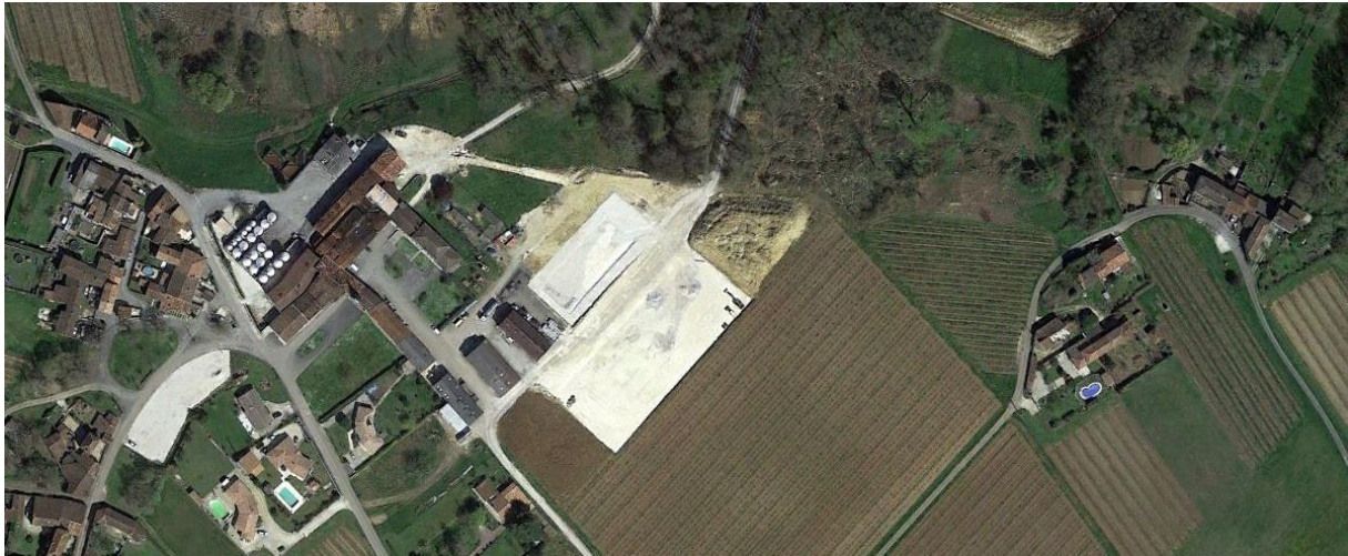
Source – Géoportail – Le chai n°1 est en cours de construction. Le terrassement pour le chai n°2 est en cours.
