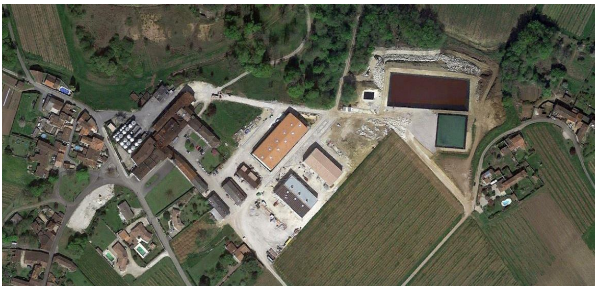
Source Géoportail – Les chais n°1 et 2 et le hangar sont construits, ainsi que le bassin à vinasses et la réserve en eau.
