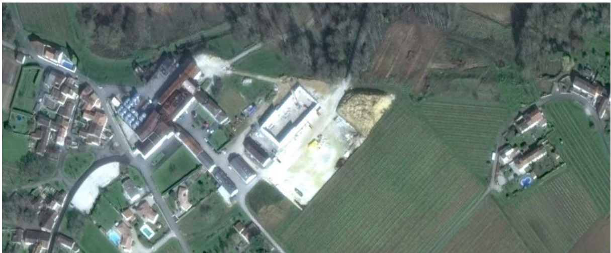
Source – Mapstreetview – Le chai n°1 est en cours de construction. Le terrassement du chai n°2 est en cours.
