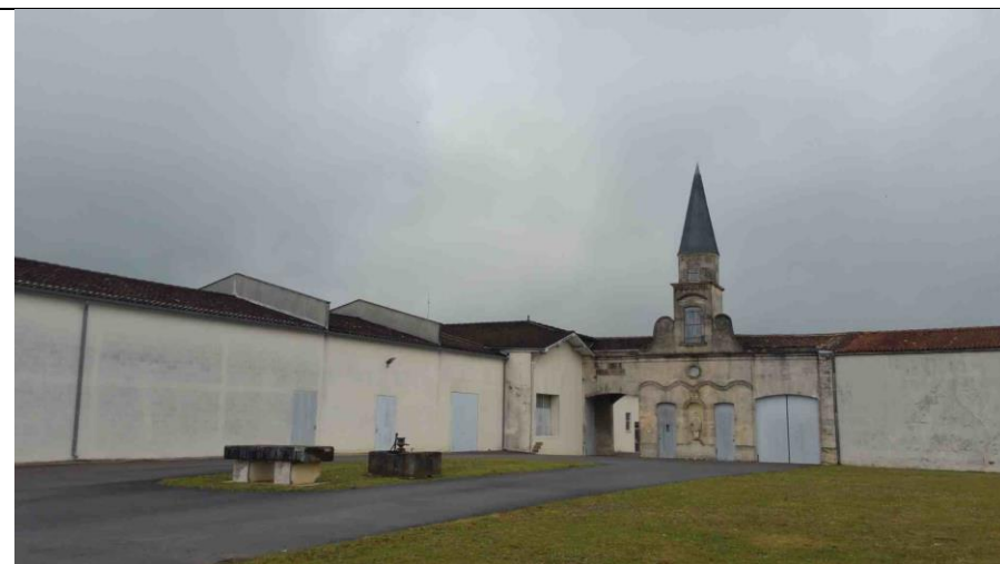
Repère n°24 – Entrée du site
