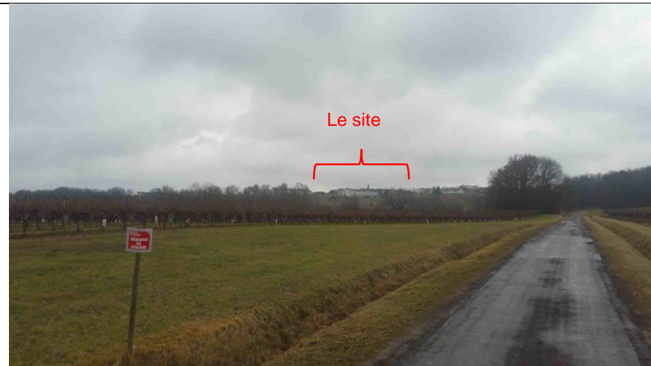
Repère n°26– (nouvelles constructions non visibles)
