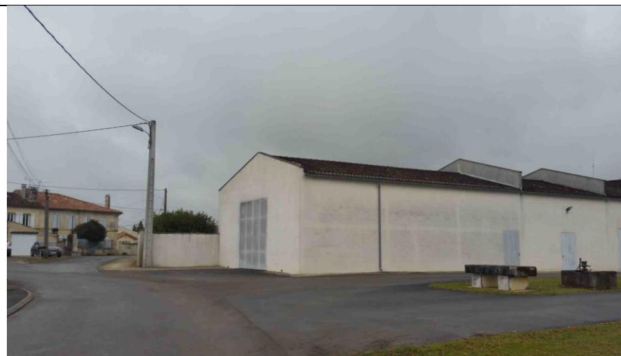
Repère n°25 - Entrée du site
